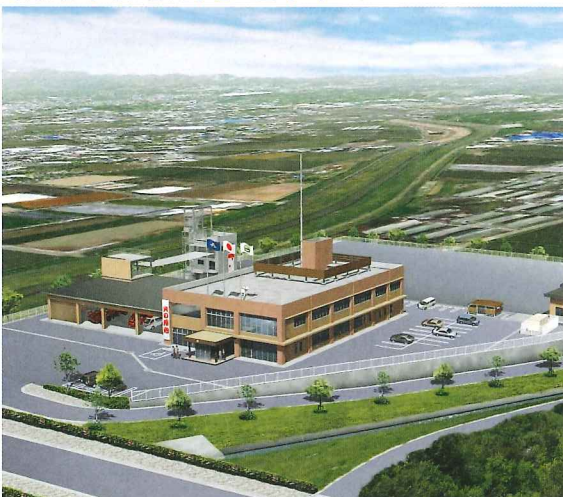
新庁舎は、現在整備中の掛浜バイパス沿いの三沢地内に建設中です。
