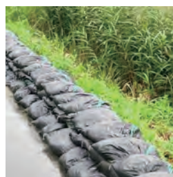
▲設置した土のう
