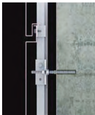
▲鋼製下地を壁や柱に固定
