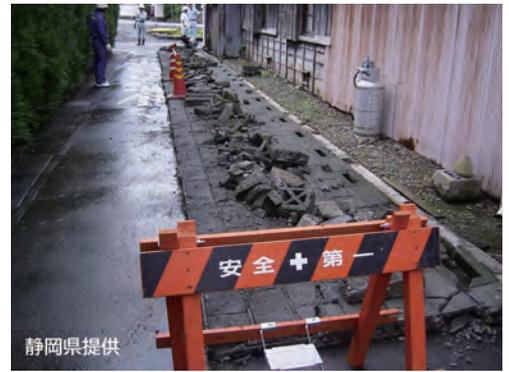
▲平成21年8月発災の駿河湾を震源とする地震で倒壊したブロック塀(静岡県提供)
