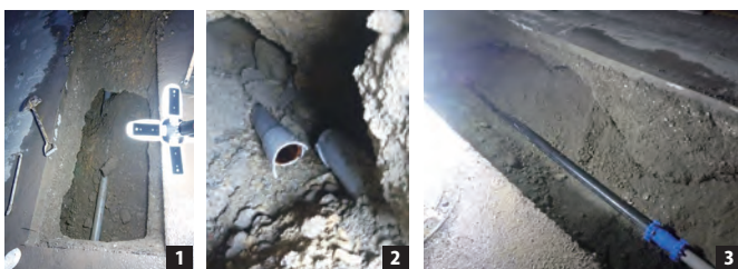
1 破損箇所を確認 2 接合部の破損を確認 3 復旧完了
