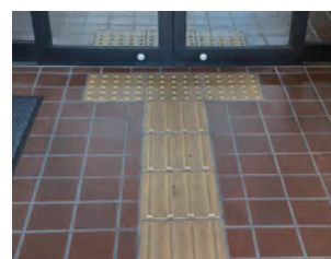
▲市役所本庁舎内の点字ブロック
