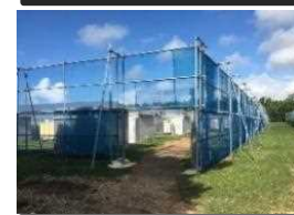
防風ネットの設置
