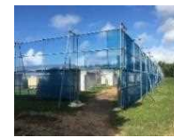
防風ネットの設置
