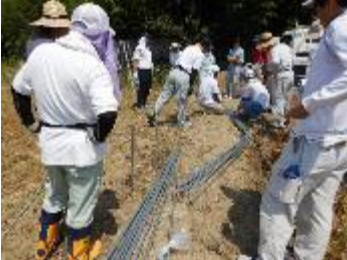
災害復旧の取組実証
