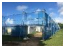
防風ネットの設置
