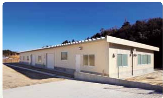
大型防災倉庫
