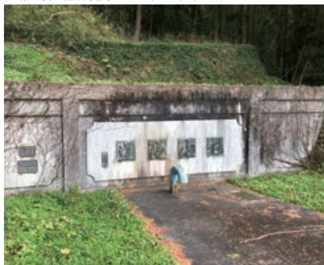
社山隧道 中遠地域の水不足解消のため明治18（1885）年に用水用のトンネル工事に着手した
