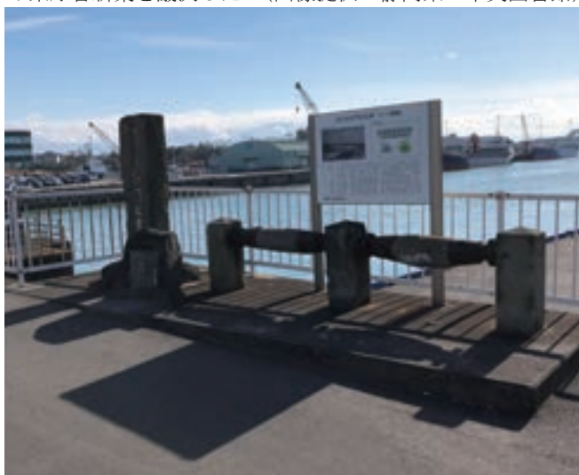
沼川石水門 富士山麓浮島沼周辺の「逆潮」被害を防ぐための石水門。静岡県で初めてセメントを使って構築されている
