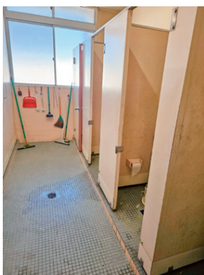
改修前の小学校のトイレ
