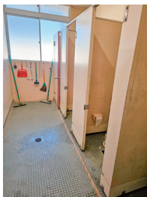
改修前の小学校のトイレ
