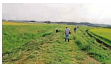
県管理河川高橋川草刈り状況
