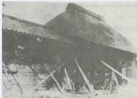
▲昭和東南海地震の被災住宅（下平川） 傾いた家を丸太で支えてある様子
