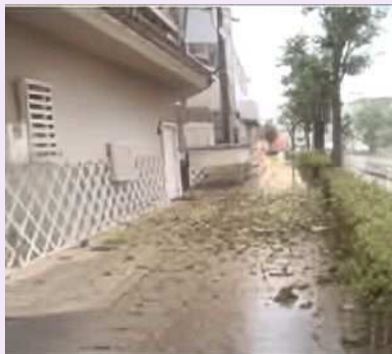
▲写真は駿河湾地震当時の菊川市の被害状況▶
