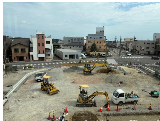
▲駅南駅前広場の整備状況
