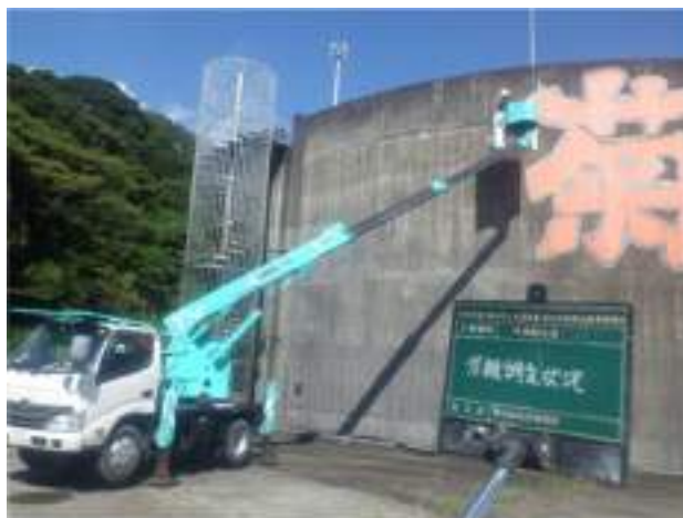
配水池初期点検の状況
