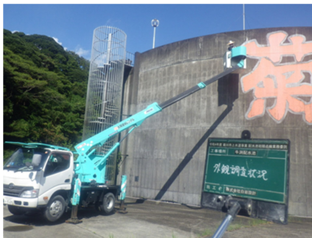
配水池初期点検の状況
