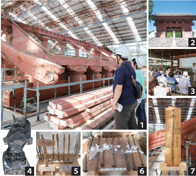
①間近で鑑賞する屋根の迫力に圧倒 ②保存修理工事前の山門 ③専門家からの説明に熱心に耳を傾ける ④取り外した東西の 鬼瓦(上が西、下が東) ⑤上棟式で使われた道具類 ⑥取り外 された吊金物 ⑦移築時の棟札(建物の改修工事の際に記録とし て棟木などの高い場所に設置される木札)
