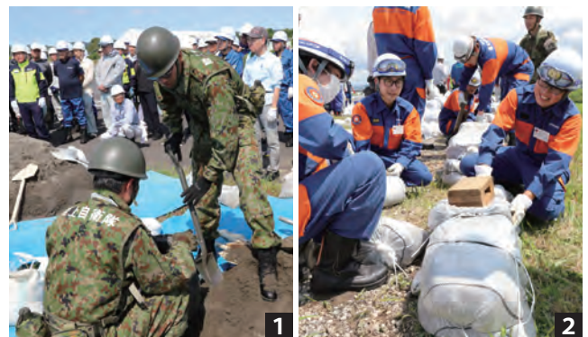
1自衛隊より土のう作りをレクチャー 2叩いてより強固な土のうを積み上げていく
