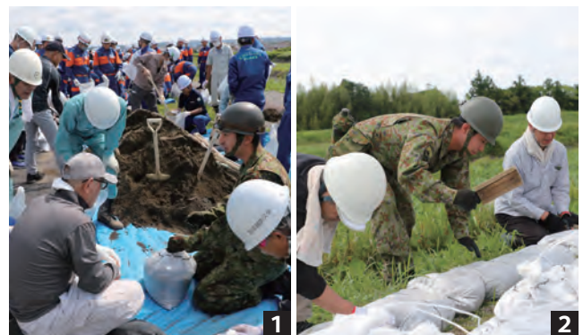
1 劣化を防ぎながら土のうを作成 2 叩きながら強固に積み
