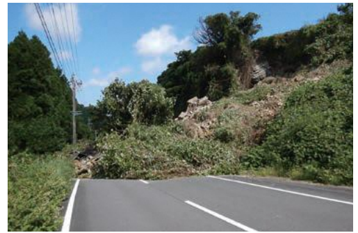
▲昨年9月の台風15号で発生した土砂崩れ
