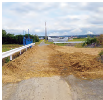
▲令和元年台風19号の影響で道路に流れ出た稲わら(嶺田地区内)
