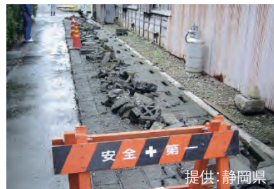
▲倒壊して道路をふさいだブロック塀
