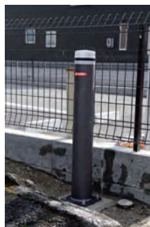
▲設置されたボラード
