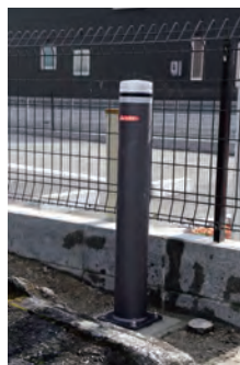
▲設置されたボラード
