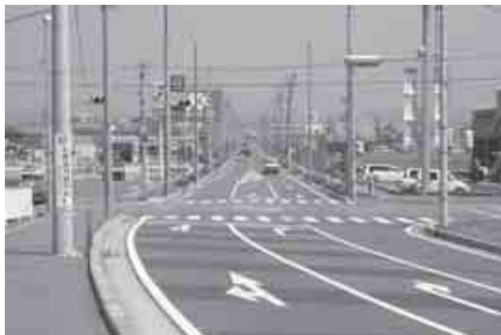
(主)掛川浜岡線バイパス(宮の西地内)
