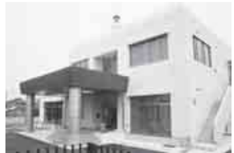
平川コミュニティ防災センター
