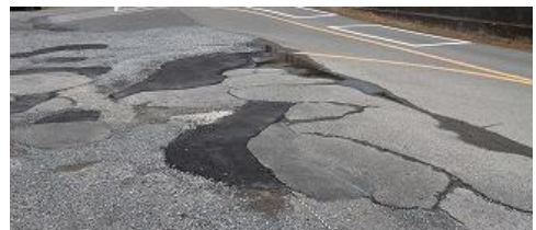
駐車場の舗装
