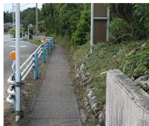
駐車場・通学路の草刈り
