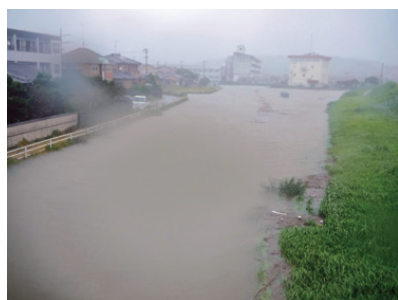
黒沢川排水機場
