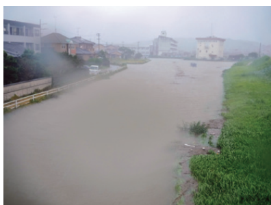
黒沢川排水機場
