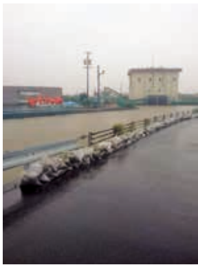
台風19号(令和元年10月12日)時の黒沢川右岸/岳洋中学校駐車場付近
