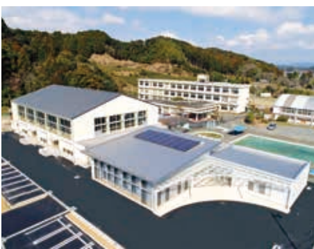
太陽光発電設備が設置された内田地区センター
