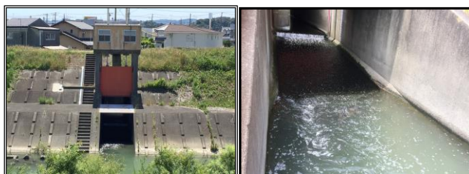
※五丁目樋管 菊川駅付近から下水道供用開始区域を通り、一級河川菊川に流れる樋管
