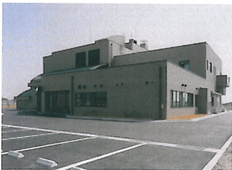
管理汚泥棟 北西側外観
