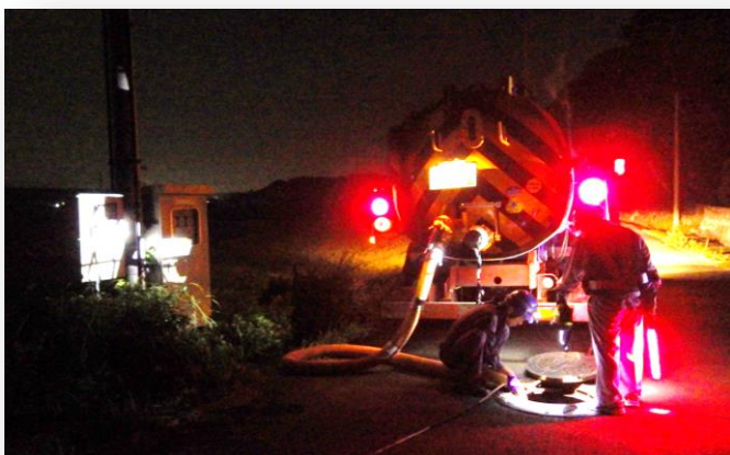
睦橋西マンホールポンプ 【発電機による電源確保（置型）】
