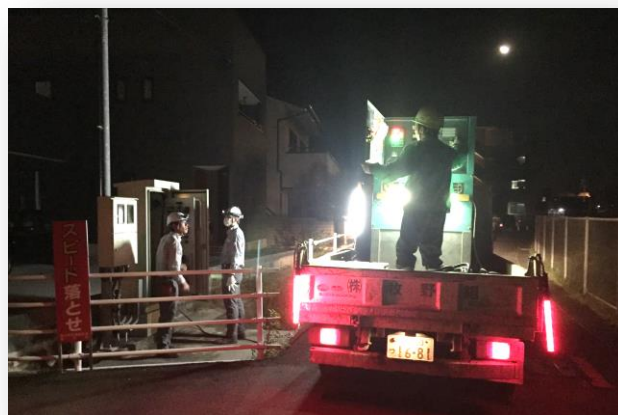
西中前マンホールポンプ 【発電機による電源確保（移動型）】
