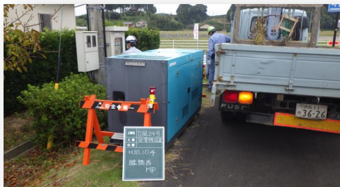
睦橋西マンホールポンプ 【発電機による電源確保（置型）】
